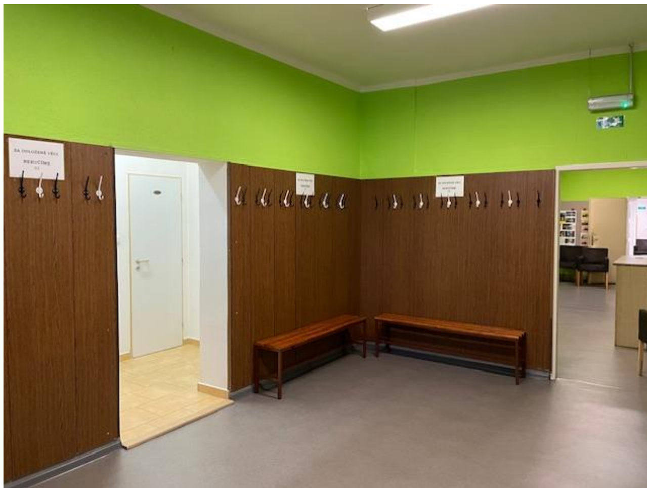
Obrázek č. 17 – věšáková stěna před rekonstrukcí
