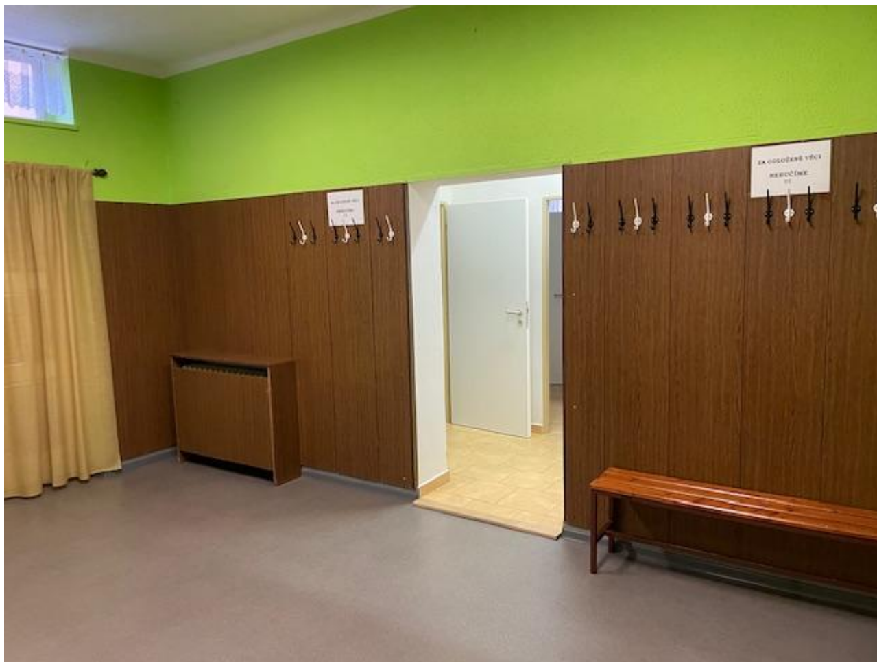
Obrázek č. 16 – věšáková stěna před rekonstrukcí
